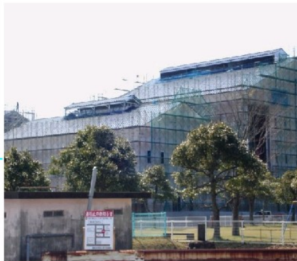
霧島酒造工場建設現場 写真のような建物が3棟建設中
