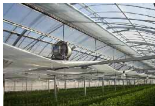
内張り二重構造・循環扇
